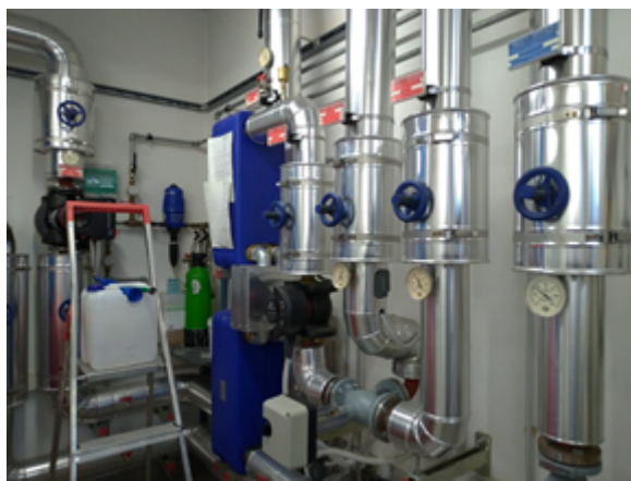
Fig. 2 – scambiatori di calore produzione acqua calda sanitaria
