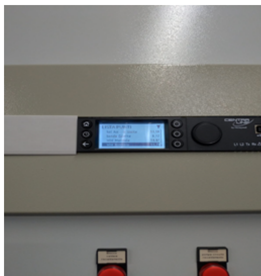
Fig 4 - Centralina di controllo parametri impianto acqua calda e programmazione shock termici
